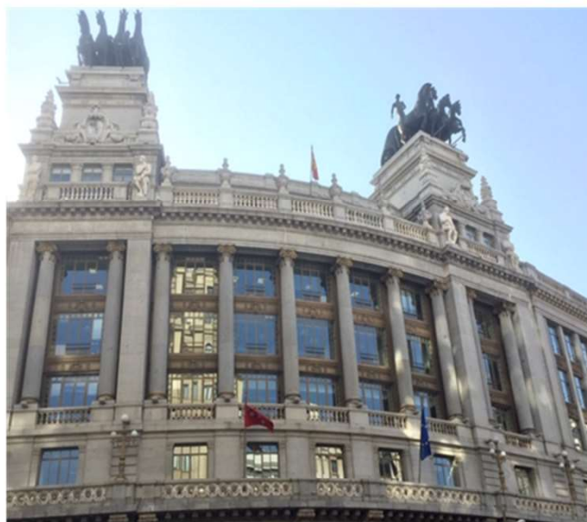
Sede de la Consejería de Medio Ambiente y Ordenación del Territorio de la Comunidad de Madrid
