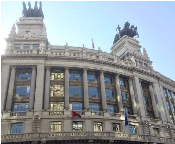
Sede de la Consejería de Medio Ambiente y Ordenación del Territorio de la Comunidad de Madrid
